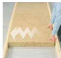
Подожмите пружинящий край и вставьте другую сторону
