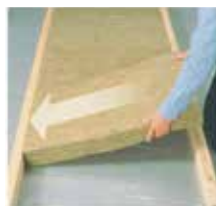
Вставьте плиту одной стороной в каркас
