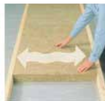
Отпустите плиту и она плотно встанет в каркас
