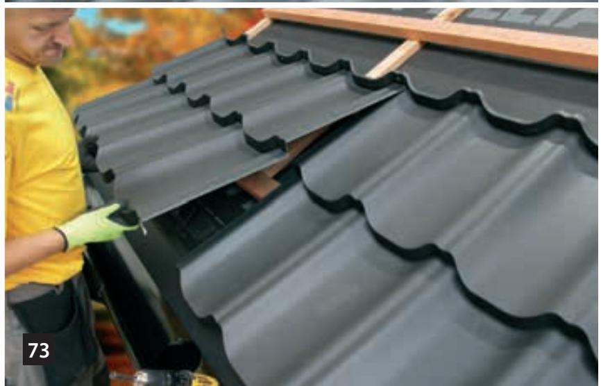
укладку нужно с правой стороны и низа ската (со стороны карнизного свеса) с цельного модуля, но при этом нужно отступить примерно 350 -550 мм от линии сопряжения ската. Место положения по высоте определяется верхним краем 3 обрешетки так, чтобы верхний срез модуля соответствовал верхнему краю 3 обрешетки.
