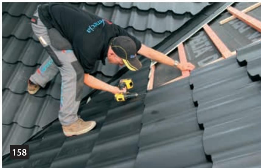
край листа расположен четко над направляющей линией и то, что монтажные верхние и нижние отверстия (слева) у подрезанного модуля и уложенных ранее модулей совпали между собой (см. фото №170-172). При совпадении нижнего и верхнего монтажного отверстия укладываемого модуля с массивом модулей с лева – произвести фиксацию (скрутку) только через верхнее монтажное отверстие, с помощью саморезов Ws. Таким же образом произвести монтаж всех оставшихся ендовых подрезных модулей до карниза.
