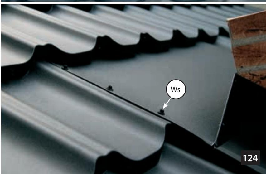
**ВАЖНО:** укладка подрезанных модулей (с низу/права от элемента проходки) производится непосредственно на цельные модули, а обрезанные концы должны заводятся под детали внешнего фартука (см. фото №113-116, 119- 121, 123).
