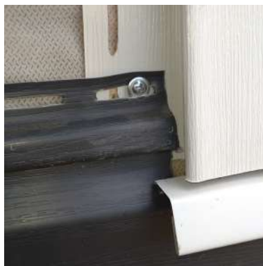
Саморез вкручен в тело доборного элемента и в край перфорации сайдинга.
