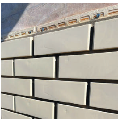
Монтаж без обрешетки.
