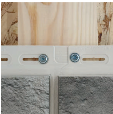
Саморезы в тело материала и край перфорации.
