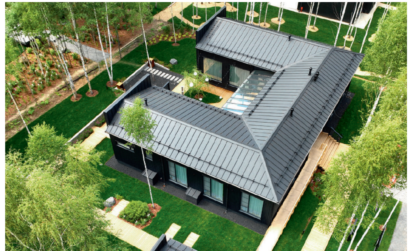
Кликфальц® Pro в покрытии Satin Matt, RAL 9005 Снегозадержатели для фальцевой кровли Grand Line, RAL 9005 Кровельная и стеновая лестницы Grand Line, RAL 9005 Металлический водосток Vortex Matt, RAL 9005
