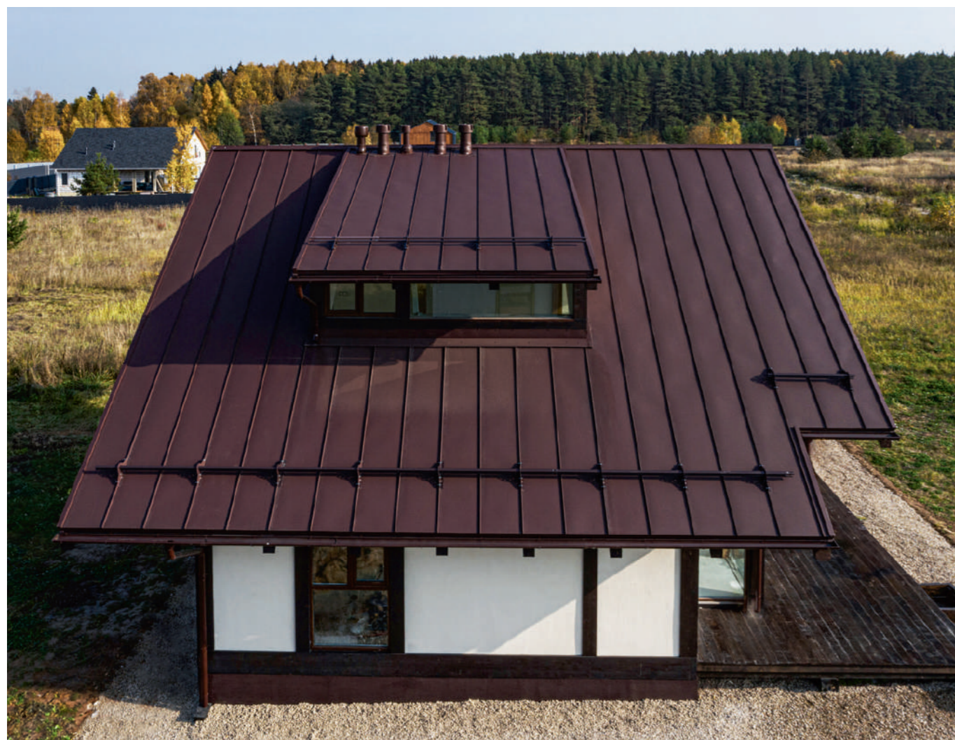
Кликфальц® в покрытии Drap, RAL 8017 Снегозадержатели для фальцевой кровли Grand Line, RAL 8017 Металлический водосток Grand Line PU 125x90, RAL 8017
