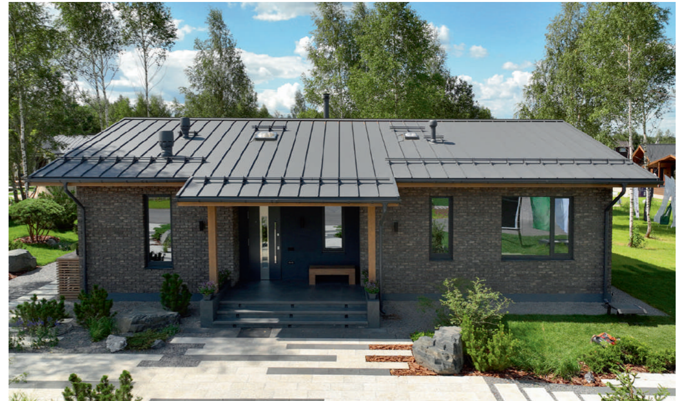
Кликфальц® Pro в покрытии Satin Matt, RAL 7024 Снегозадержатели для фальцевой кровли Grand Line, RAL 7024 Металлический водосток Grand Line PU 125x90, RAL 7024
