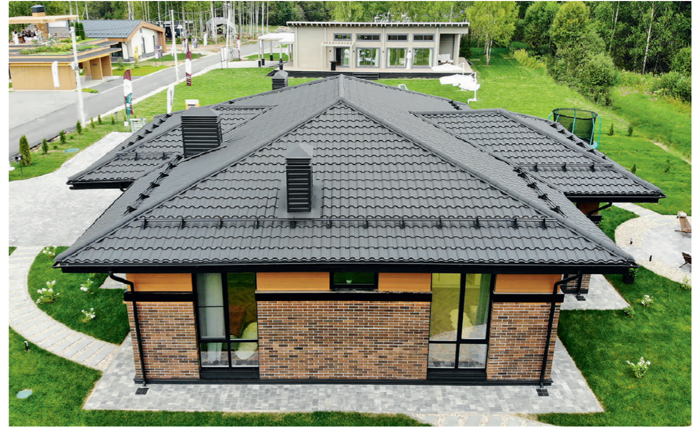
Металлочерепица Кредо в покрытии Drap TX, RAL 9005 Металлический водосток Grand Line PE Matt 125x90, RAL 9005 Снегозадержатели Grand Line, RAL 9005
