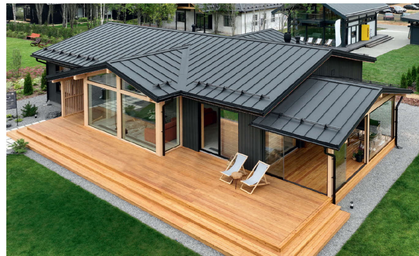
Кликфальц® Pro в покрытии Satin Matt, RAL 9005 Снегозадержатели для фальцевой кровли Grand Line, RAL 9005 Металлический водосток Grand Line PU 125x90, RAL 9005
