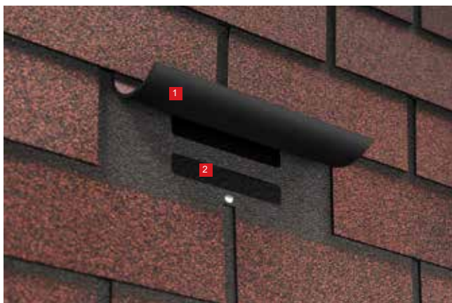
Битумная сварка гонтов: клей (2) на чистый битум (1). В три раза прочнее обычного клеевого соединения.
