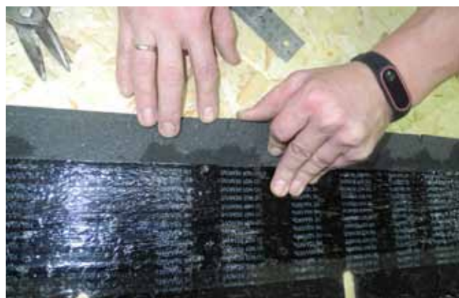
Рис. 12. Насечка для облегчения монтажа
