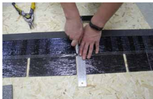
Рис. 13. Деление плитки на лепестки
