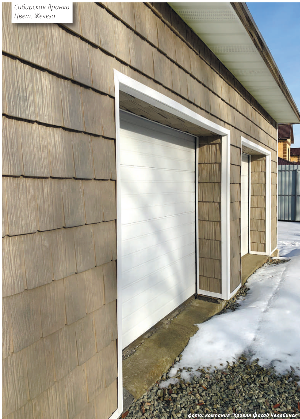
фото: компания "Кровля Фасад Челябинск"
