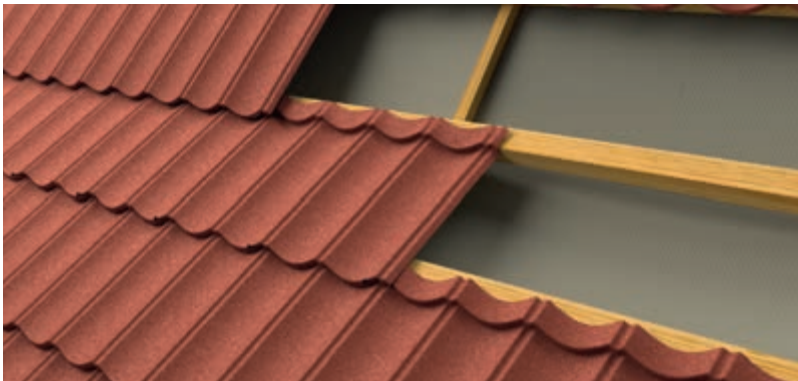
Рис. 35 Монтаж на внутреннем переломе ската
